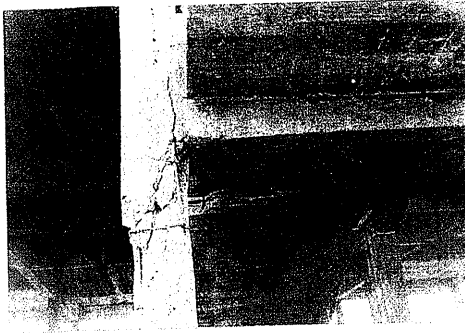
Şekil 6. Kolonda Sıkıştırılmamış Etriyenin ve Kalitesiz Betonun Neden Olduğu Ağır Hasar (İTÜ Yapı-Deprem Arşivi)
