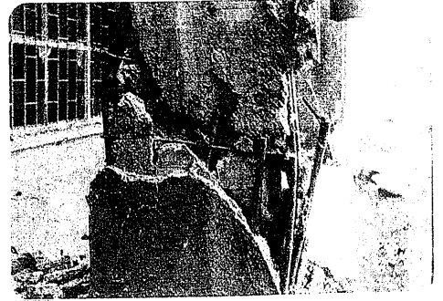
Şekil 7. Yetersiz Filiz Boyundan Sınıfına Uygun Olmayan Betondan Kaynaklanan Ağır Kolon Hasarı (İTÜ Yapı-Deprem Arşivi)
