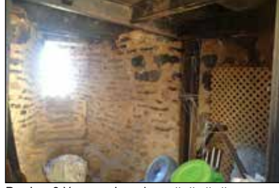
Resim-3 Yapının içerden görünüşü
