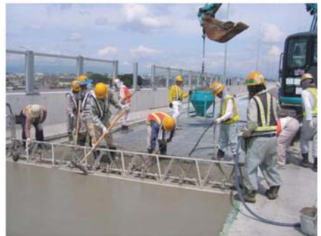
Şekil 4 - Yeni OÇT'de kısa başlı bulonlarla birlikte ÇLGB kaplama
