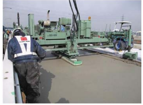
Şekil 3 - Asfalt kaplamanın yerine ÇLGB uygulaması
