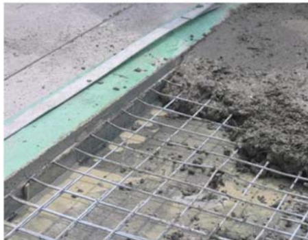
Şekil 4 - Yeni OÇT'de kısa başlı bulonlarla birlikte ÇLGB kaplama
