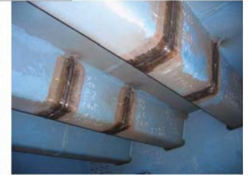
Şekil 9 - Ark üfleme işlemi sonrası burulma rijitlikli boyuna nervürlerin küt kaynaklı birleşimlerinin tekrar kaynaklanması
