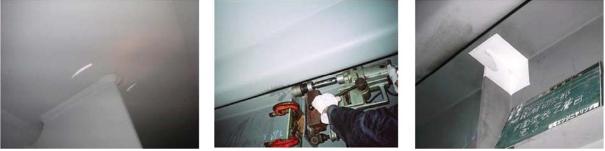
Şekil 10 - Yorulma açısından kritik bölgeyi yarım daire şeklinde oyarak gerilme yığılmasını azaltmak ve yorulma çatlakları ilerlemesini durdurmak
