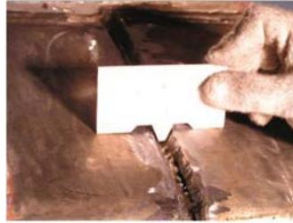
Şekil 9 - Ark üfleme işlemi sonrası burulma rijitlikli boyuna nervürlerin küt kaynaklı birleşimlerinin tekrar kaynaklanması
