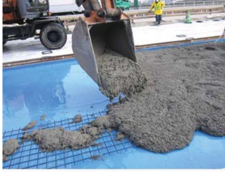
Şekil 3 - Asfalt kaplamanın yerine ÇLGB uygulaması
