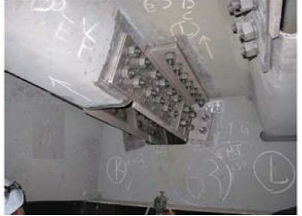
Şekil 8 - Değişirme ve yüksek mukavemetli bulonlarla teşkil edilen eklerle güçlendirme
