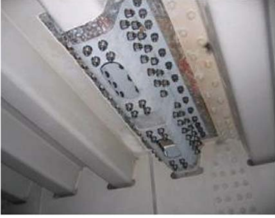
Şekil 8 - Değişirme ve yüksek mukavemetli bulonlarla teşkil edilen eklerle güçlendirme
